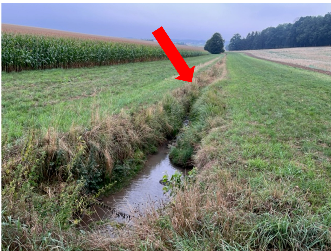
Abbildung 6: Einleitungsstelle Gießüblgraben, Fl.-Nr. 1500
