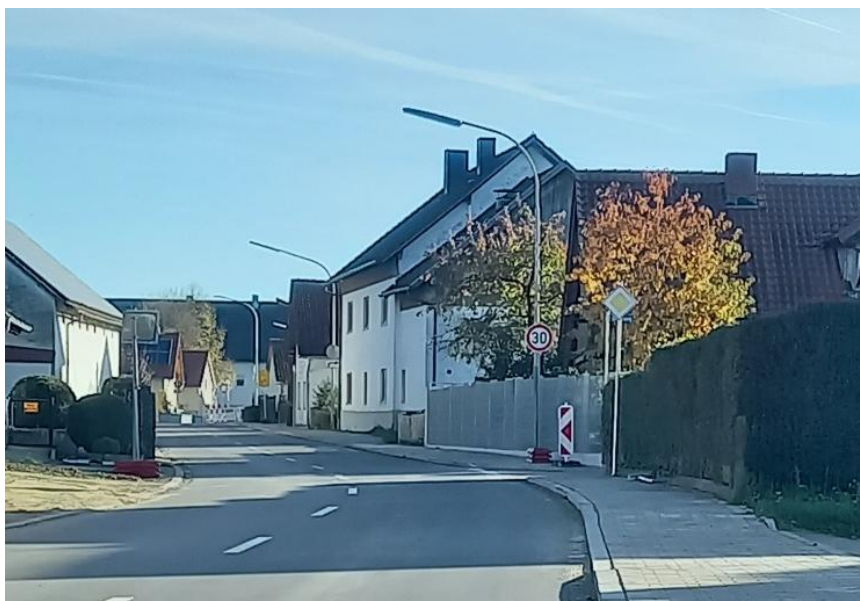
Sanierung Kanal + Gehweg in der Dorfstraße, Dornwang (DGF 10)
