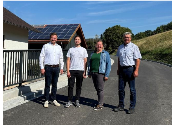
Sanierung Hofmarkstraße, Forst mit Ingenieurbüro S 2
